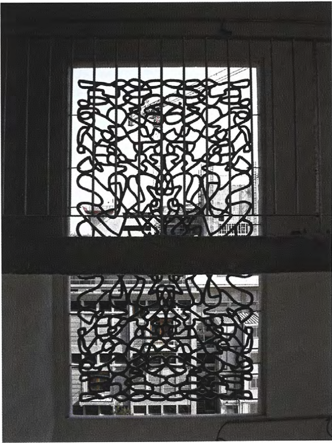
Tous les panneaux ont été fabriqués dans le même moule et ont ensuite été découpés en fonction des dimensions des fenêtres.
